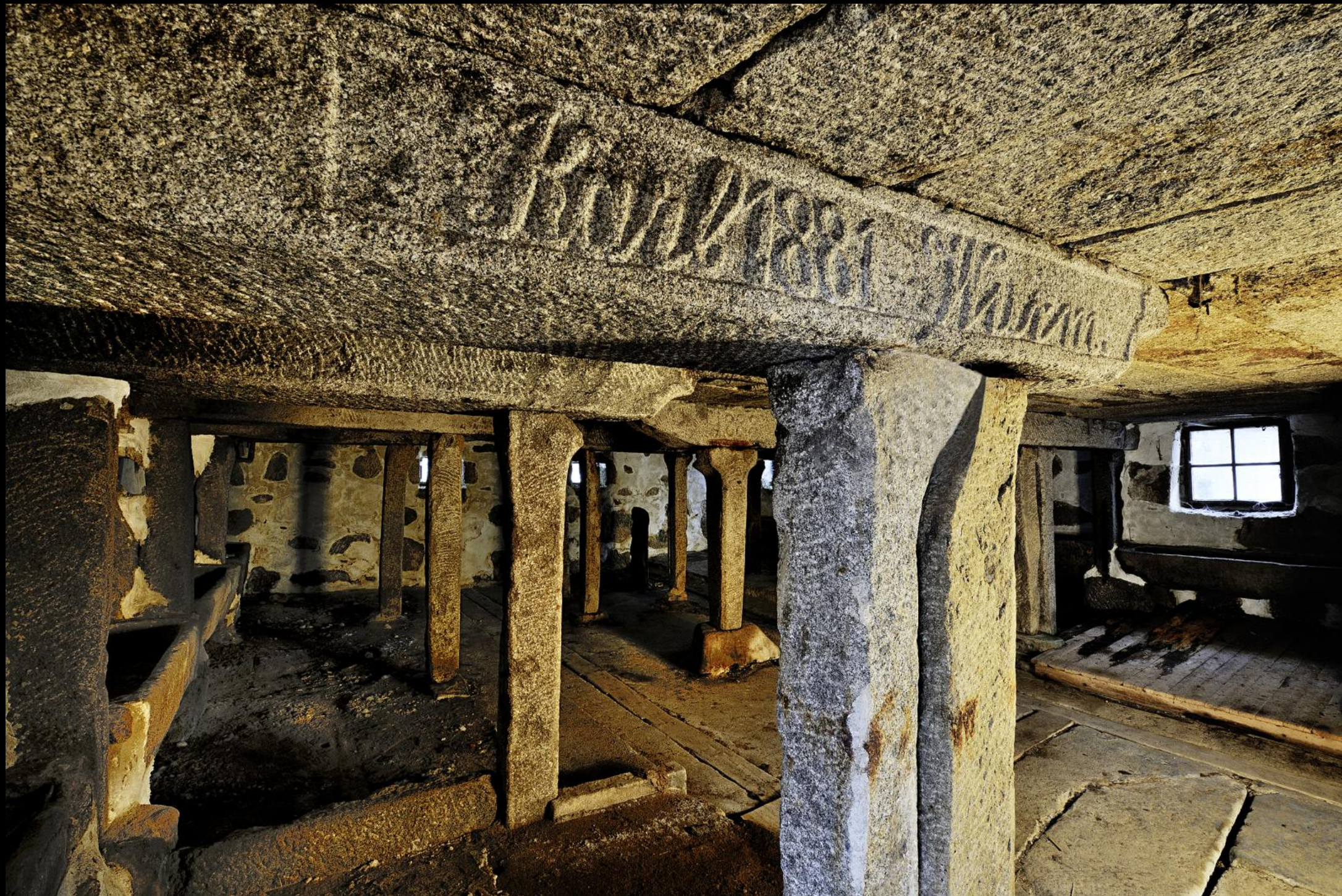
Der massiv aus Granit gebaute Kuhstall trägt die Initialien des Hobby-Steinmetzes Karl Wurm, der den Hoisen-Hof gemeinsam mit seinen zwei Brüdern 1881 gebaut hat.
