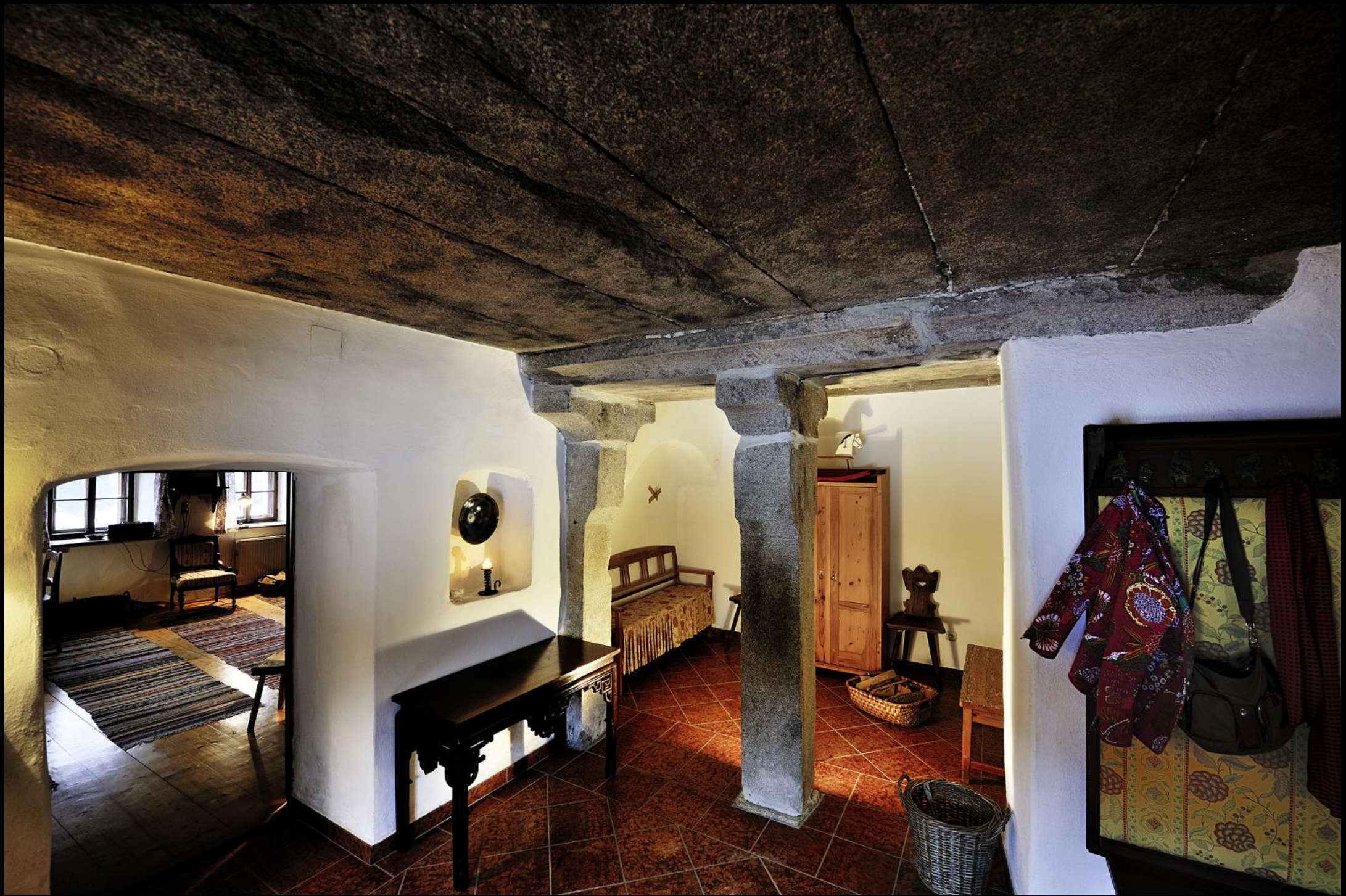
Eingang mit massiver Granit-Decke am Hoisen-Hof.
