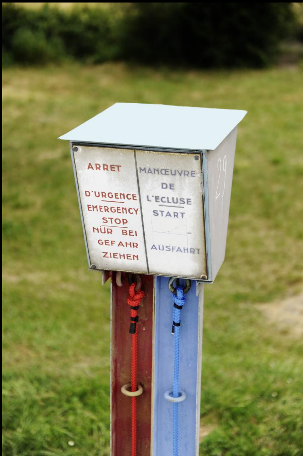
Schleusen-Weiche zum Selbst-Öffnen bei unbesetzten Schleusen.
