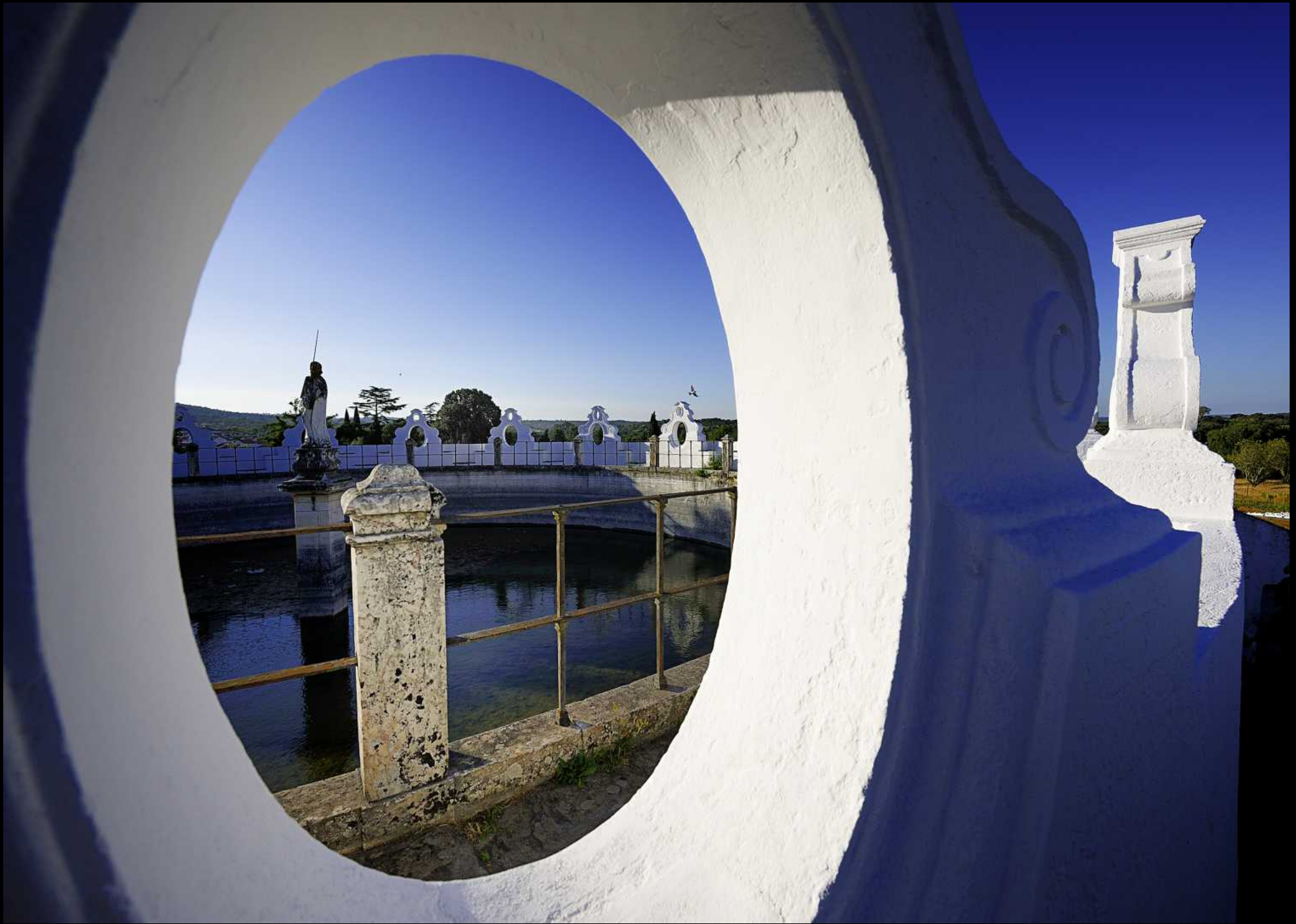
Aquädukt "Aqueduto da Agua de Prata"
